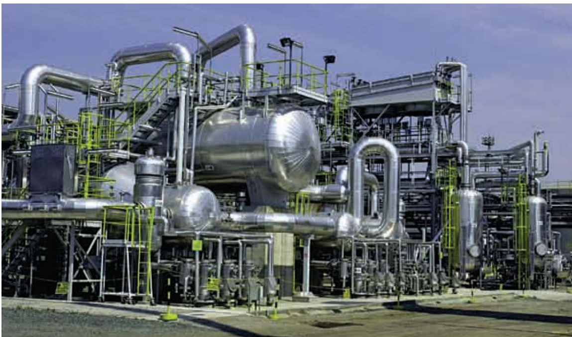
Výstavba nové jednotky Claus umožnila splnit požadavky na odstranění sulfanu z odpadních plynů.
