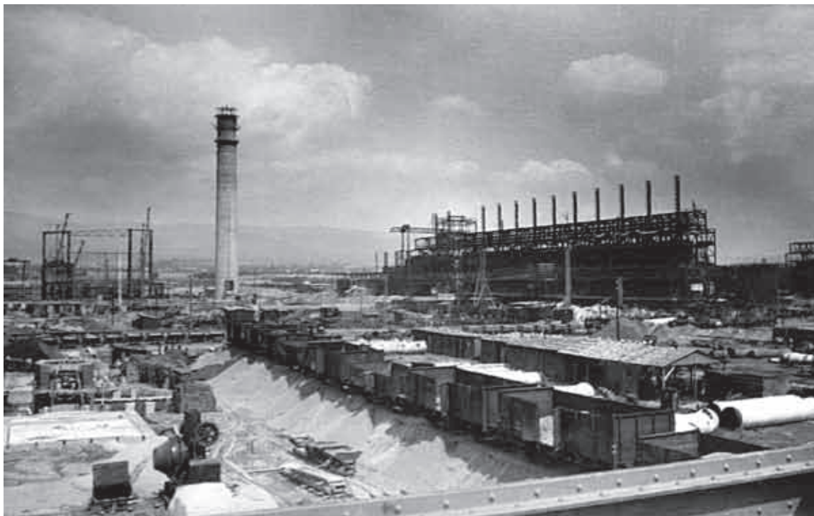
Stavba karbonizací a teplárny T-200 – 1. komín a základy zauhlování (budoucí zásobník na 10 000 tun uhlí)
