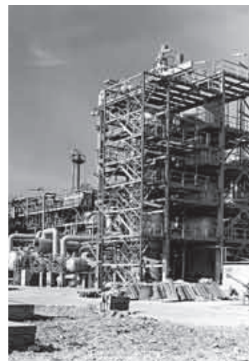
Stavba reaktorů PSP, v pozadí výměňková řada
