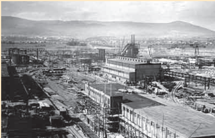
Stavba budovy hlavních laboratoří, v pozadí stavba Winklerových generátorů
