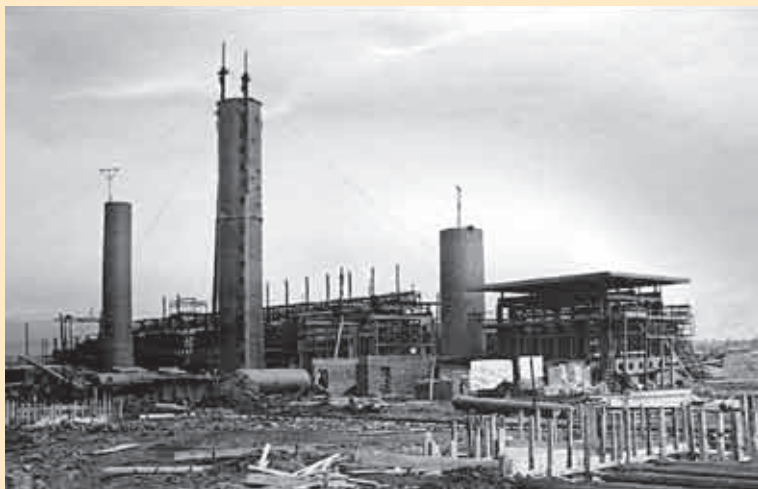
Stavba teplárny T-200 (již třetího komínu) a karbonizace
