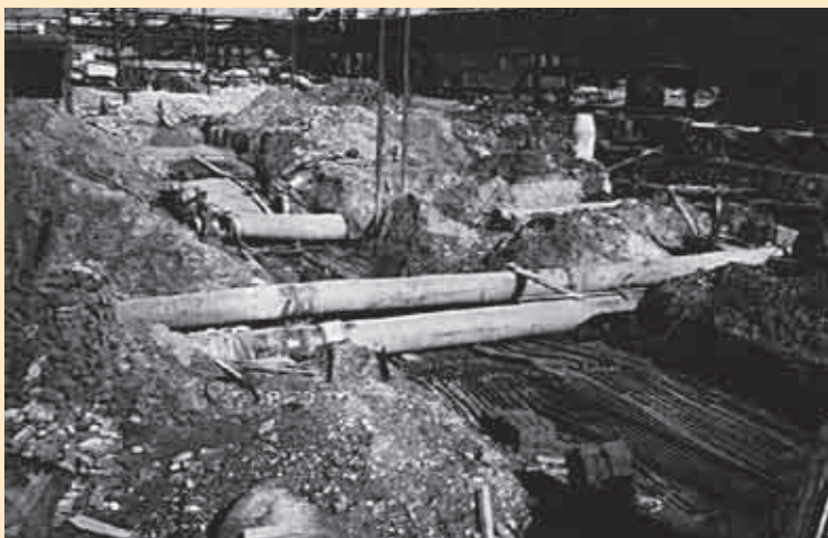
Oprava podzemních rozvodů
