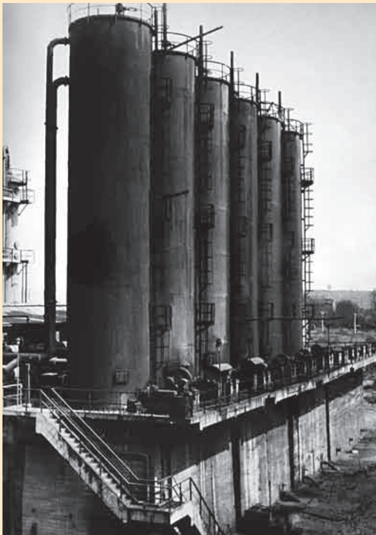
Tlaková plynárna – vodní vypírka, regenerační věže z jihu
