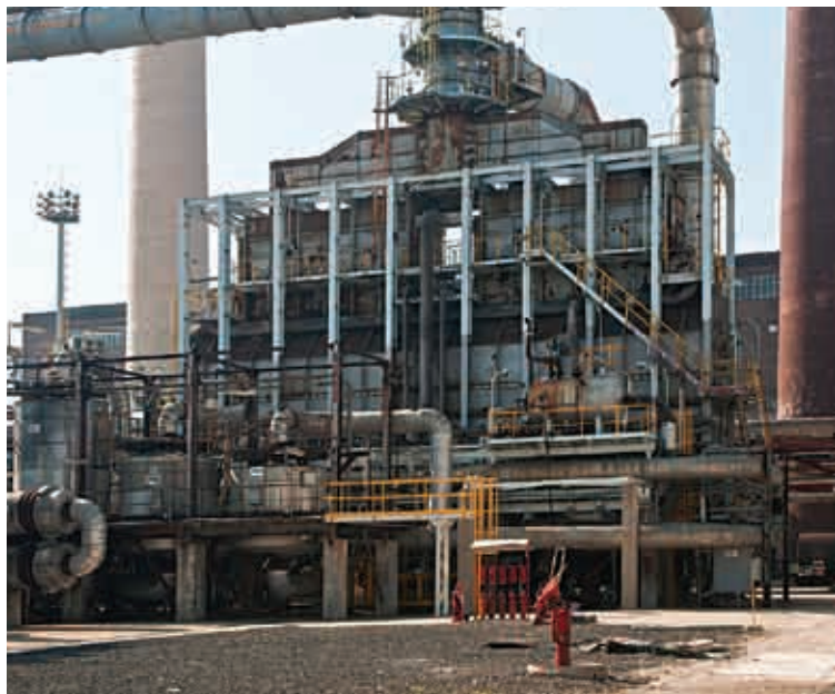
Reaktory a pece semiregenerativního reformingu v rámci komplexu NRL
