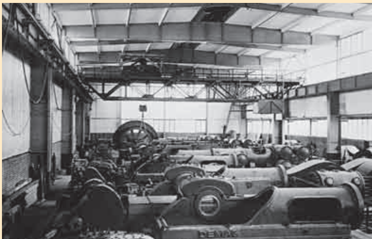
Stavba strojovny vysokotlakých kompresorů „Demag“
