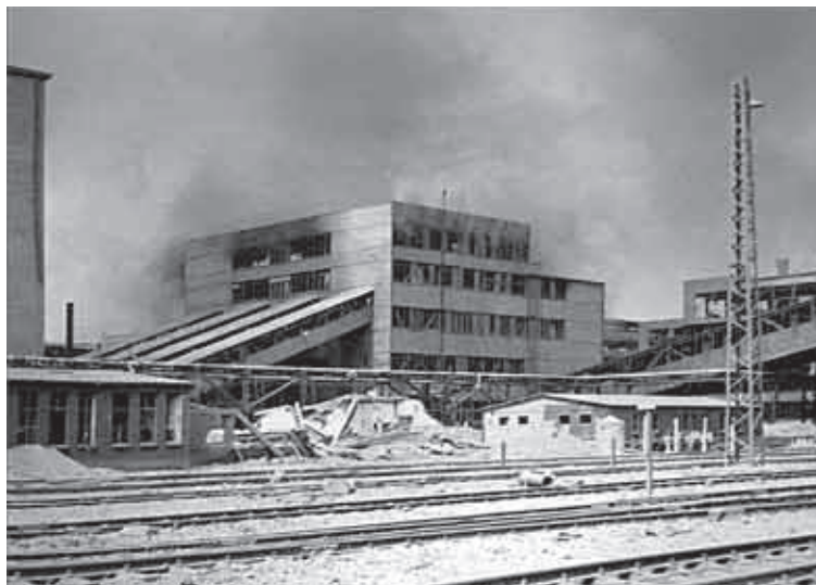
Poškozená třídírna uhlí 1. zauhlovací řady
