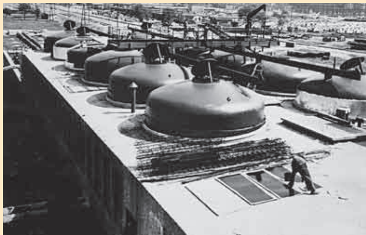
Stavba odsíření vodního plynu před dokončením
