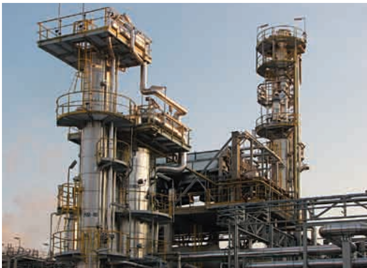
Program Čistá paliva zahrnoval mj. výstavbu nového reaktoru hluboké desulfurace plynového oleje v litvínovské rafinérii (vlevo) a výstavbu jednotky selektivní hydrodesulfurace krakového benzínu v kralupské části (vpravo).
