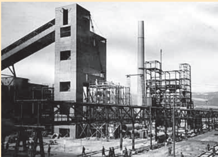
Stavba tlakové plynárny
