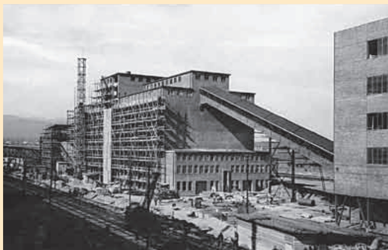
Stavba portálového jeřábu nad komorami hydrogenací
