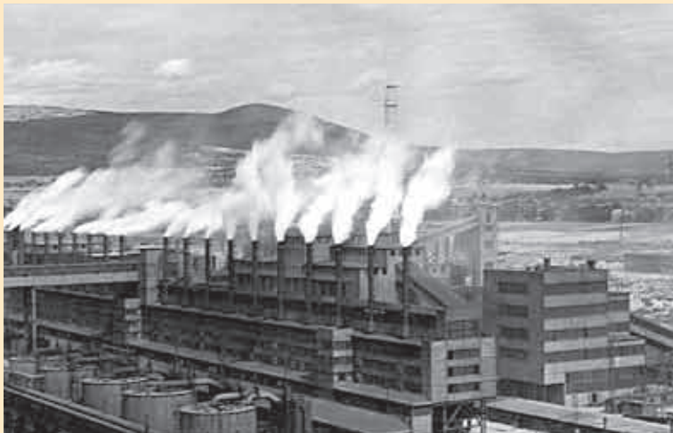
Část karbonizací – již v plném provozu
