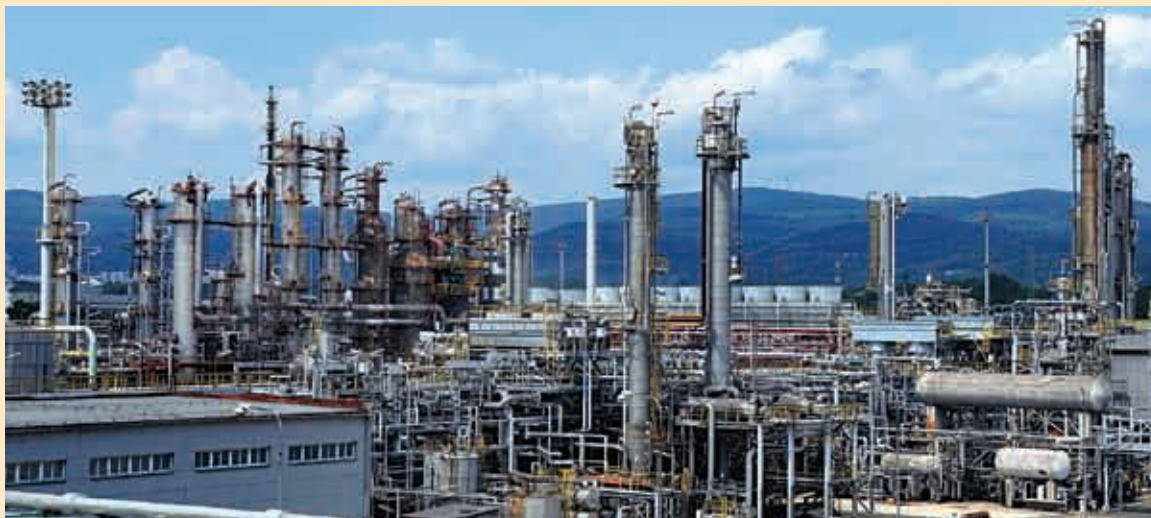
Moderní část litvínovské rafinérie, v popředí hydrokrakovací jednotka.
