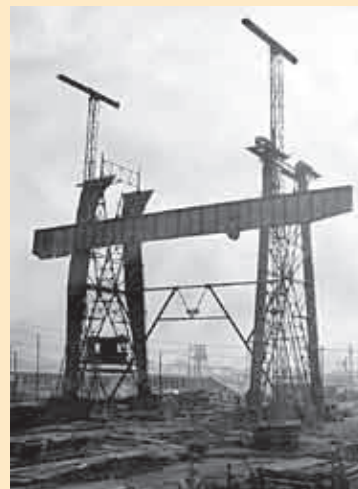
Stavba portálového jeřábu nad komorami hydrogenací
