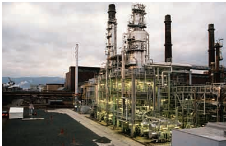
Slavnostní zahájení provozu (vlevo) jednotky visbreaking (vpravo), zajišťující zužitkování těžkých ropných frakcí.
