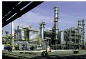
Visbreaker der Česká rafinérská
