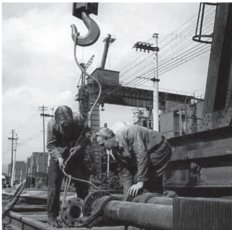
Příprava pecní trubky (vlásenky) pro předehříváč hydrogenační komory
