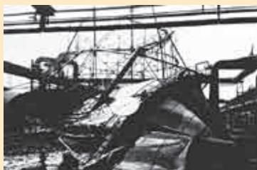
Zničený plynovod vodního plynu
