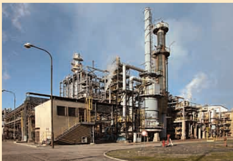
Moderní část litvínovské rafinérie, v popředí hydrokrakovací jednotka.
