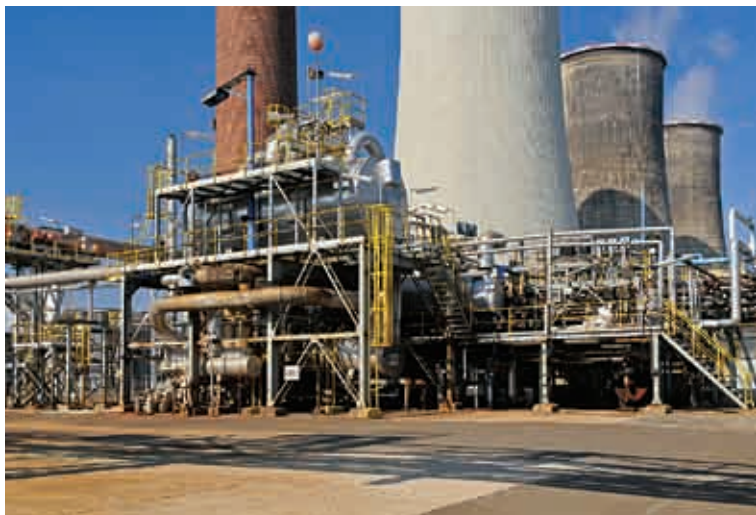
Zařízení Claus II bylo od roku 2005 mimo provoz, protože nedosahovalo požadované účinnosti.
