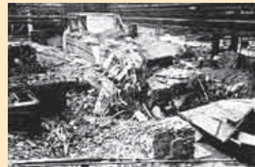
Zásah do trafostanice
