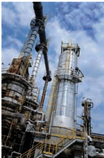
Program Čistá paliva zahrnoval mj. výstavbu nového reaktoru hluboké desulfurace plynového oleje v litvínovské rafinérii (vlevo) a výstavbu jednotky selektivní hydrodesulfurace krakového benzínu v kralupské části (vpravo).
