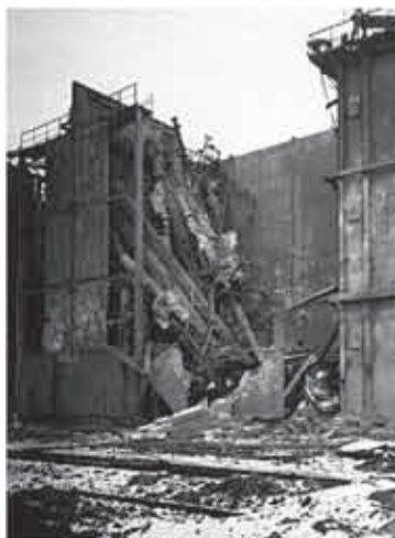
Komora hydrogenace po přímém zásahu
